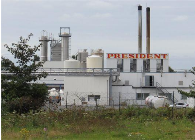
Traitement des eaux usées d'usines fromagères
