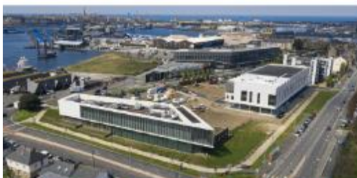
Centre Mondiale de l'Innovation Roullier (CMI) - SAINT-MALO
