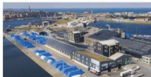
Usine du Qual Intérieur - SAINT-MALO
